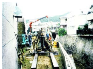
①機材搬入状況
