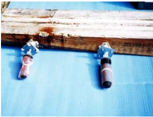
①エポキシ樹脂試験注入
