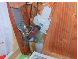
①エポキシ樹脂注入
