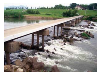
躯体補修・橋脚補強・保護塗装 完了状況
