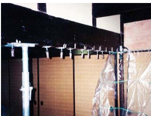
⑤エポキシ樹脂注入
