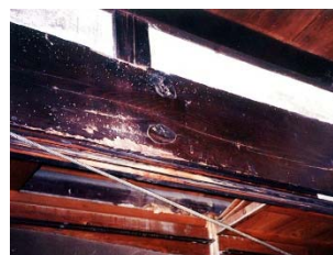
③施工前状況
