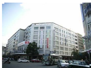
高島屋京都店 耐震補強工事
