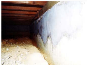
③下地処理完了
