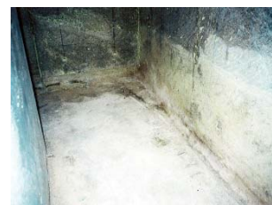
②施工前状況
