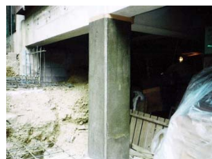
②プライマー塗布
