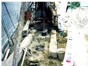
②ケーシング挿入状況
