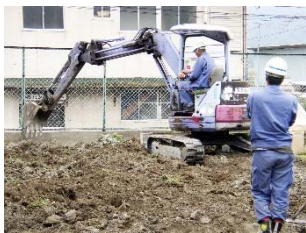
②地盤改良材の混合・攪拌状況
