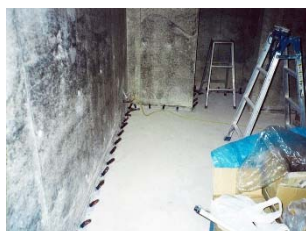
⑤エポキシ樹脂注入
