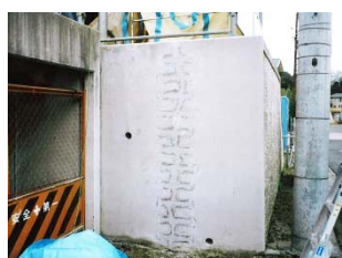
④アンカー筋設置完了
