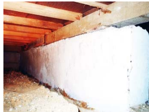
④エポキシ樹脂パテ塗布完了
