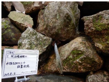
⑦水抜き加工シート設置完了
