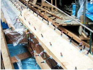
隅木埋め木接着 (エポキシ樹脂注入)
