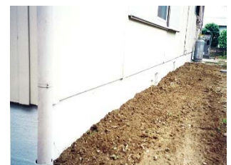
④完了（モルタル刷毛引き）
