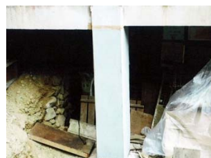
③エポキシ樹脂パテ塗布
