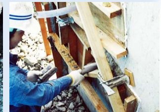
②型枠＋無収縮モルタル注入
