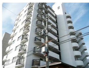
マンション 大規模修繕工事
