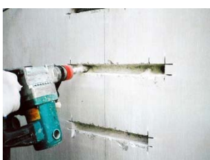
②アンカー孔はつり状況
