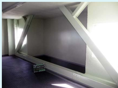
鉄骨ブレース工法
