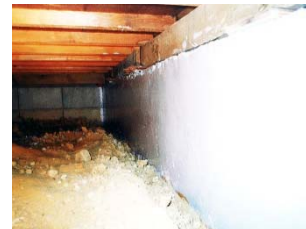
⑤エポキシ樹脂塗料塗布完了
