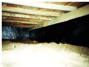
②炭素繊維シート貼付け完了
