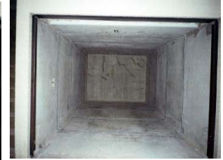
⑧施工完了
