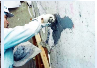
②ポリマーセメントモルタル 充填
