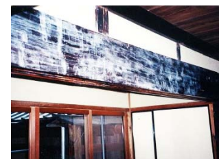
④汚染防止塗膜塗布
