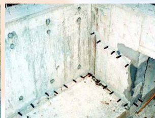
エポキシ樹脂注入
