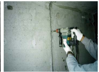
④目地部モルタル撤去
