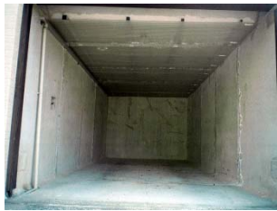
①施工前現況
