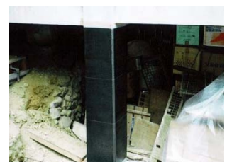
④炭素繊維シート貼付け
