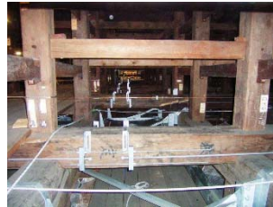
二重梁PC緊張工事
