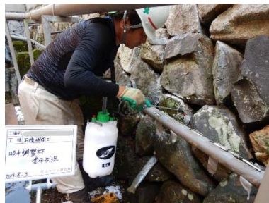
⑧目地に吸水調整剤散布
