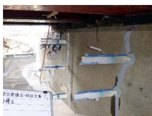
橋脚 ひび割れ部 エポキシ樹脂低圧注入状況
