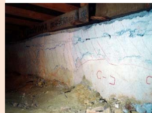
①施工前現況
