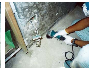
③入隅のモルタル撤去
