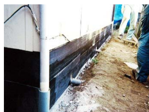
②炭素繊維シート貼付け
