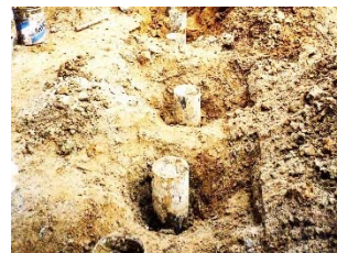
③抑止杭打設完了状況
