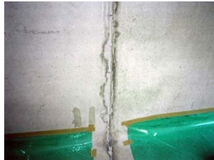
⑤欠損部補修
