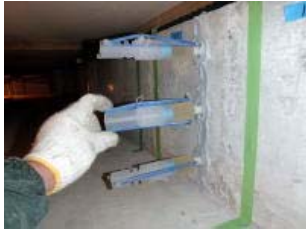
低圧エポキシ樹脂注入工法
