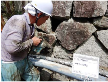
④目地モルタル撤去
