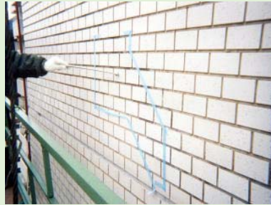
パルハンマー (浮き部打診点検)
