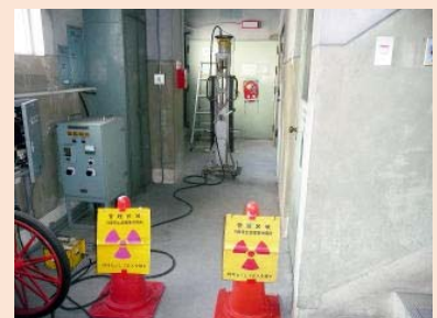
X線検査 (埋没物調査)
