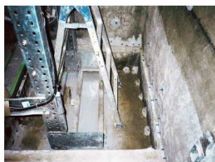
①注入用パイプ設置
