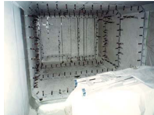
⑥エポキシ樹脂注入
