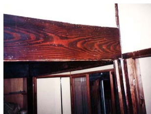
⑥汚染防止塗膜除去完了
