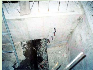
エポキシ樹脂注入
