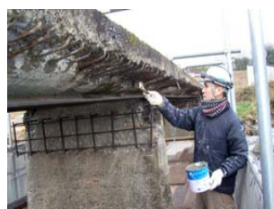
桁下面 ジャンカ部 研り後補修状況
