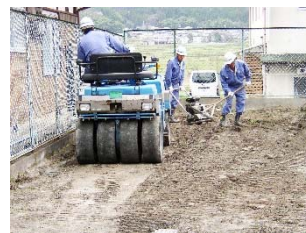
③転圧状況
