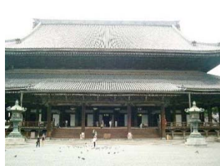
東本願寺御影堂 修復工事
