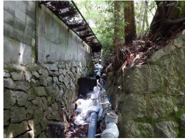
②仮設水路設置
