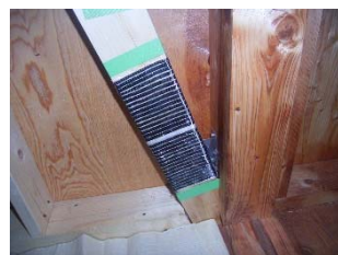
②炭素繊維シート巻き補強
