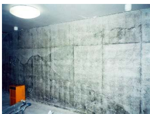
①施工前現況
