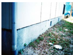
①施工前現況
