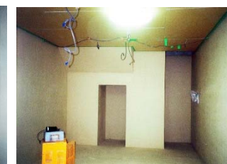
⑧シラスハルーン断熱塗装 (3回塗り)
