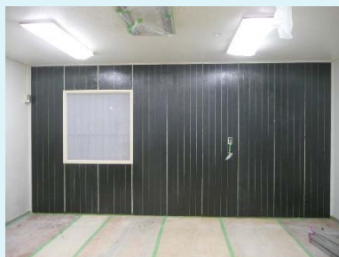
トレカクロス工法
