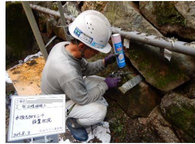
⑥水抜き加工シート設置
