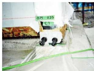
②エポキシ樹脂注入
