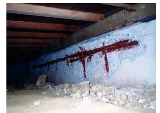
②錆鉄筋の防錆処理
