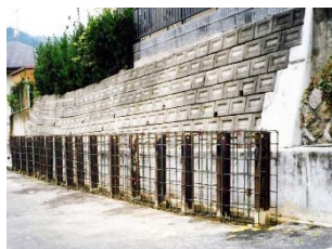
②支持杭設置、鉄筋組立状況
