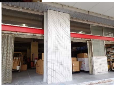
施工例（タイル仕上げ）
