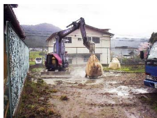
①地盤改良材の散布状況
