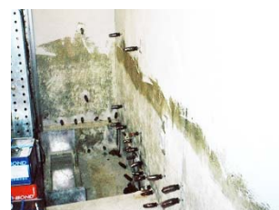
②エポキシ樹脂注入
