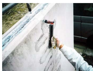
⑤エポキシ樹脂埋め戻し
