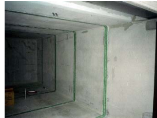
⑦目地部シーリング
