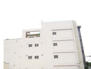
テナントビル 外壁改修工事
