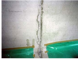
⑤欠損部補修
