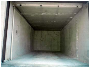
①施工前現況
