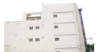
テナントビル 外壁改修工事
