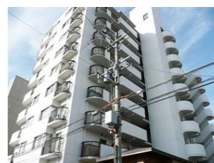
マンション 大規模修繕工事
