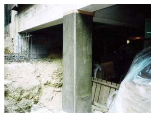
②プライマー塗布
