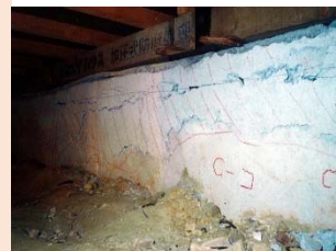
①施工前現況
