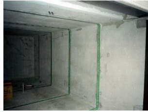
⑦目地部シーリング
