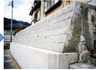
③コンクリート打設、新設間知ブロック組積完了
