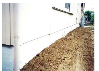
④完了（モルタル刷毛引き）
