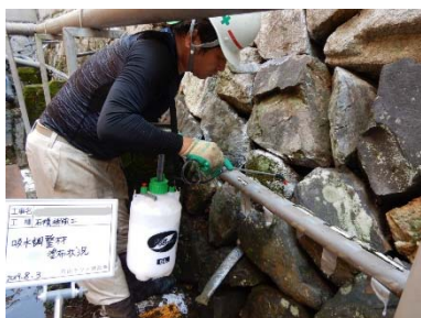
⑧目地に吸水調整剤散布
