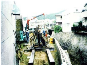
①機材搬入状況
