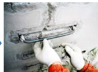
③アンカー筋設置 (エポキシ樹脂接着)
