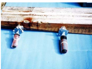
①エポキシ樹脂試験注入
