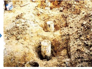
③抑止杭打設完了状況
