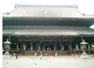
東本願寺御影堂 修復工事
