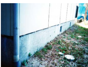
①施工前現況
