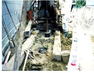
②ケーシング挿入状況
