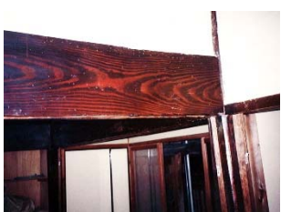
⑥汚染防止塗膜除去完了
