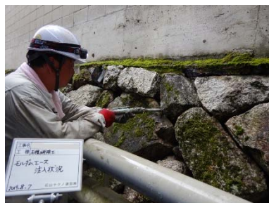
⑨モルダムエース注入
