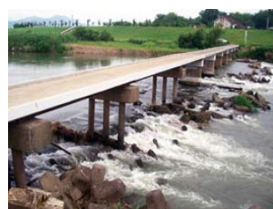
躯体補修・橋脚補強・保護塗装 完了状況
