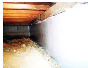
⑤エポキシ樹脂塗料塗布完了
