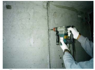
④目地部モルタル撤去
