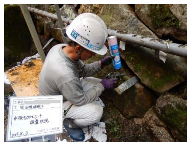
⑥水抜き加工シート設置
