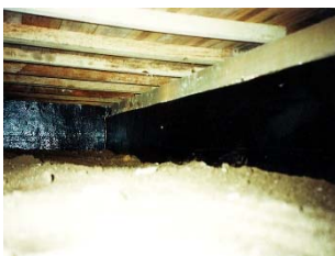
②炭素繊維シート貼付け完了
