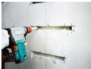
②アンカー孔はつり状況
