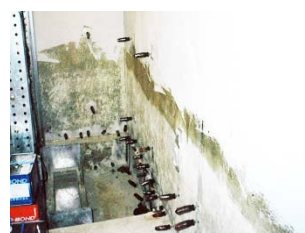
②エポキシ樹脂注入
