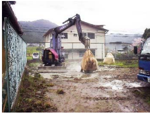
①地盤改良材の散布状況
