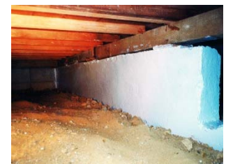
⑥アクリルウレタン樹脂塗料塗布完了
