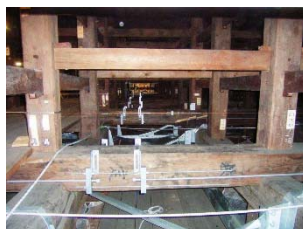
二重梁PC緊張工事
