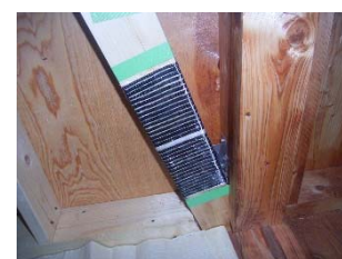
②炭素繊維シート巻き補強
