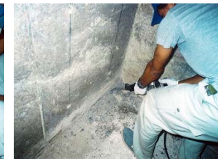
④入隅のカッター切り
