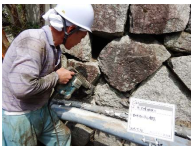
④目地モルタル撤去
