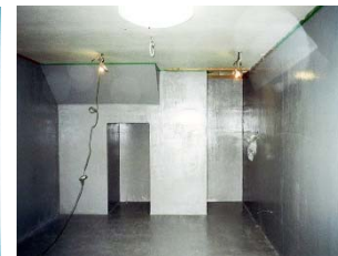
⑦クロスライニング (2層)
