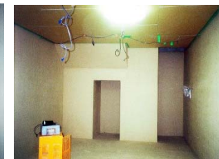
⑧シラスバレーン断熱塗装 (3回塗り)
