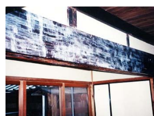
④汚染防止塗膜塗布
