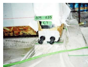
②エポキシ樹脂注入
