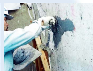
②ポリマーセメントモルタル充填
