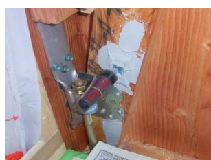
①エポキシ樹脂注入
