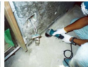
③入隅のモルタル撤去
