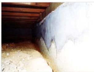
③下地処理完了
