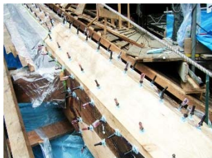
隅木埋め木接着 (エポキシ樹脂注入)
