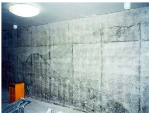
①施工前現況
