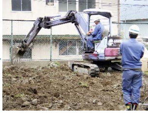
②地盤改良材の混合・攪拌状況
