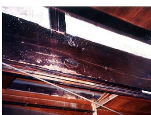
③施工前状況
