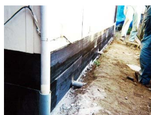
②炭素繊維シート貼付け
