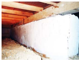
④エポキシ樹脂パテ塗布完了
