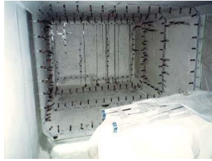
⑥エポキシ樹脂注入
