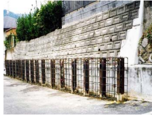
②支持杭設置、鉄筋組立状況
