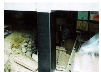
④炭素繊維シート貼付け
