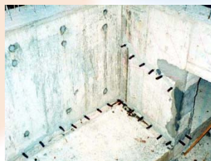
エポキシ樹脂注入
