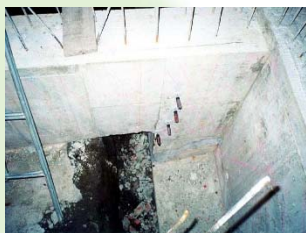
エポキシ樹脂注入
