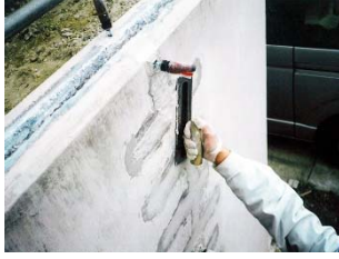
⑤エポキシ樹脂埋め戻し
