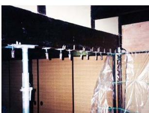
⑤エポキシ樹脂注入
