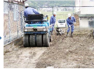
③転圧状況
