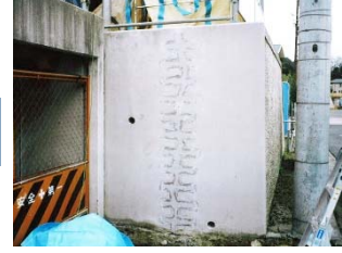
④アンカー筋設置完了
