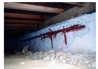
②錆鉄筋の防錆処理
