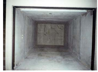
⑧施工完了
