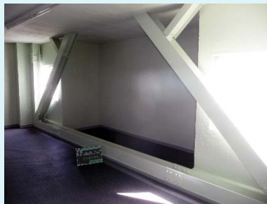
鉄骨ブレース工法
