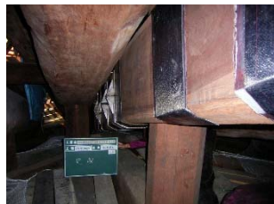
化粧隅木補強 (炭素繊維シート補強工法)
