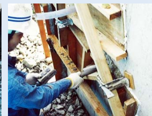
②型枠＋無収縮モルタル注入
