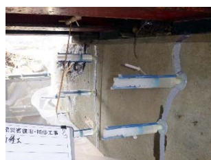
橋脚 ひび割れ部 エポキシ樹脂低圧注入状況
