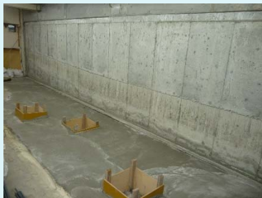
在来工法（RC耐震壁）
