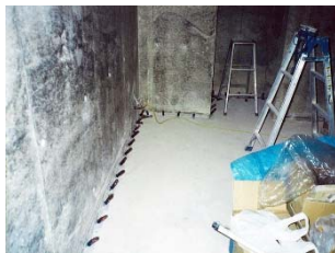
⑤エポキシ樹脂注入
