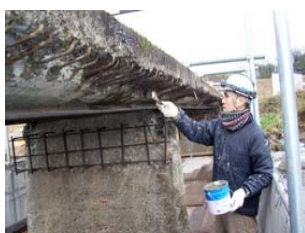
桁下面 ジャンカ部 研り後補修状況
