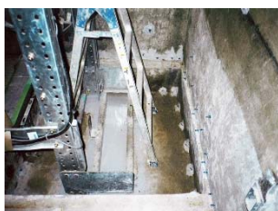
①注入用パイプ設置
