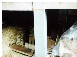
③エポキシ樹脂パテ塗布
