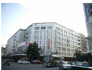
高島屋京都店 耐震補強工事
