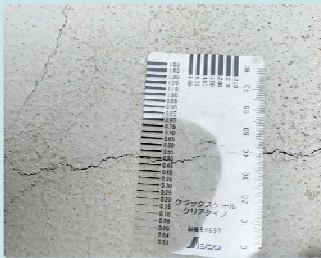
クラックスケール (ひび割れ幅測定)
