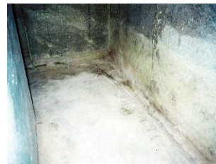
②施工前状況
