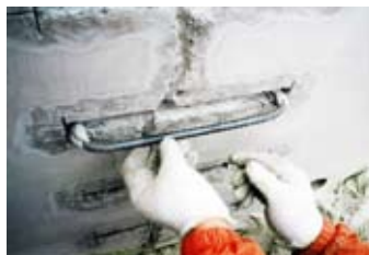
③アンカー設置（エポキシ樹脂接着）
