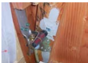
① エポキシ樹脂注入
