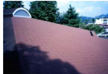
屋上防水（シングル葺き）
