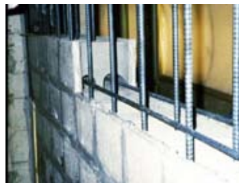
3Q-Wall 工法 施工状況
