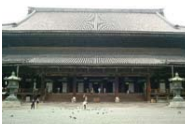
東本願寺 御影堂修復工事
