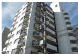
集合住宅大規模改修工事例
