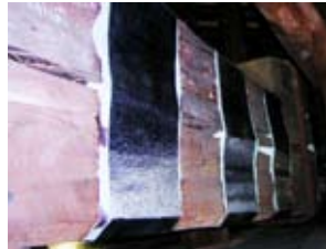
化粧隅木補強（炭素繊維シート補強工法）
