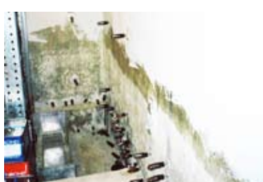
②エポキシ樹脂注入
