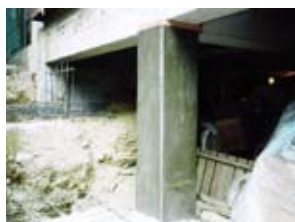
②プライマー塗布
