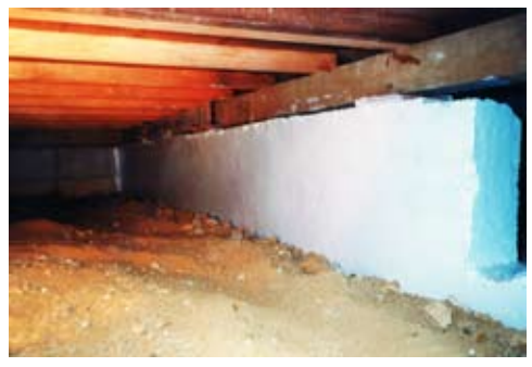
⑥アクリルウレタン樹脂塗料塗布完了
