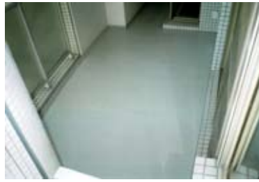
バルコニーFRP防水
