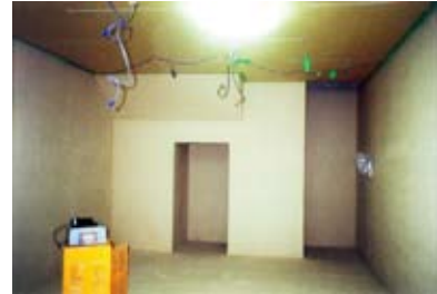
⑨シラスパルーン断熱塗装（3回塗り）
