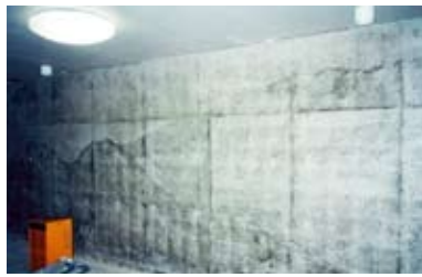
②施工前状況
