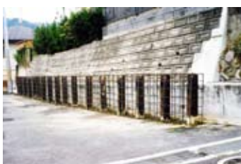
②支持杭設置及び鉄筋組み立て状況
