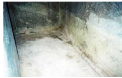
③施工前状況
