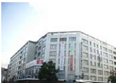
高島屋京都店 耐震補強工事
