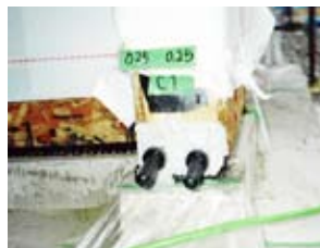
② エポキシ樹脂注入
