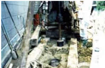
②ケーシング挿入状況
