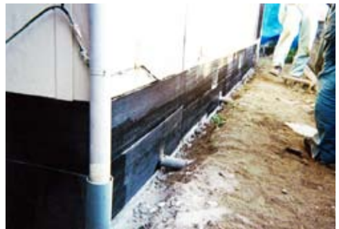
②炭素繊維シート貼付け
