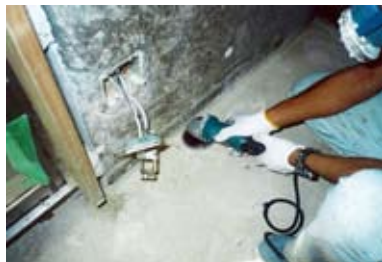
⑤入角をカッター切り
