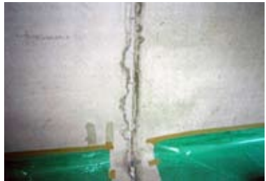
⑤欠損部補修
