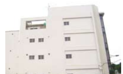
テナントビル外壁改修例
