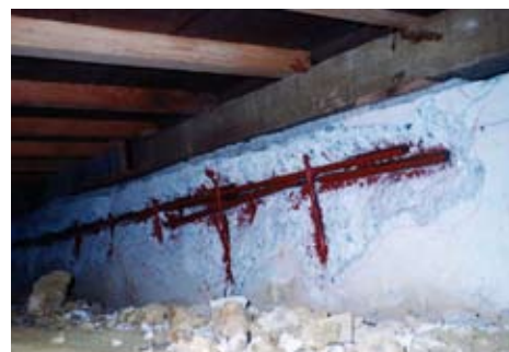
②錆鉄筋防錆処理
