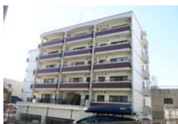
オーナーズマンション大規模改修例
