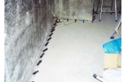
⑥エポキシ樹脂注入
