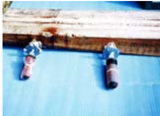
①エポキシ樹脂試験注入
