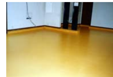
室内床MMA樹脂ライニング
