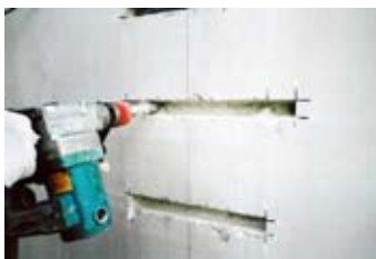
②アンカー筋設置はつり
