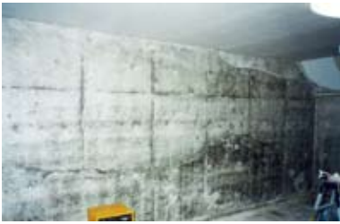
①施工前状況
