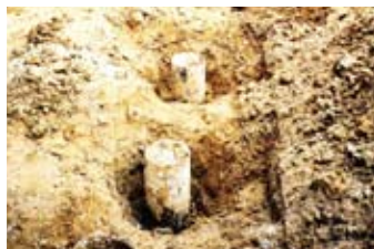
③抑止杭打設完了状況③
