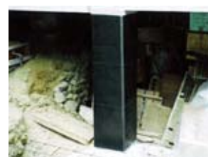
④炭素繊維シート貼付け
