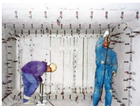
エポキシ樹脂注入
