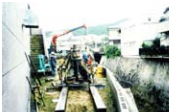
①機材搬入状況
