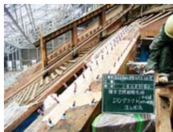
樹脂注入（ピックス工法）
