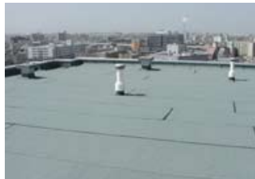
屋上防水（アスファルト冷工法）
