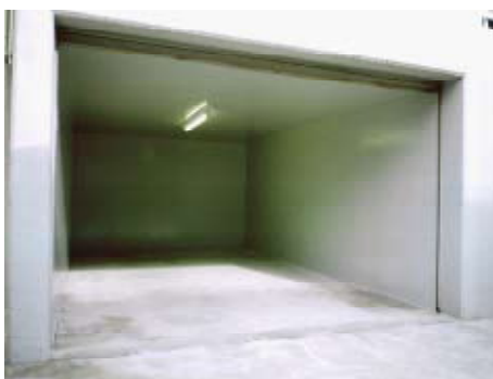
コンクリート保護工法（防水性塗装工事）
