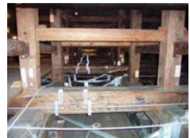
二重梁 PC 緊張工事
