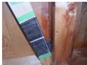
② 炭素繊維シート巻き補強
