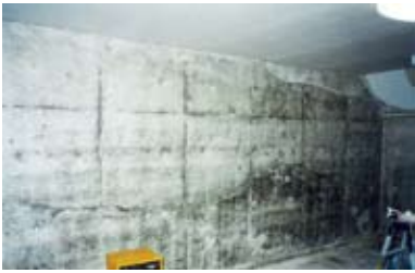
①施工前状況
