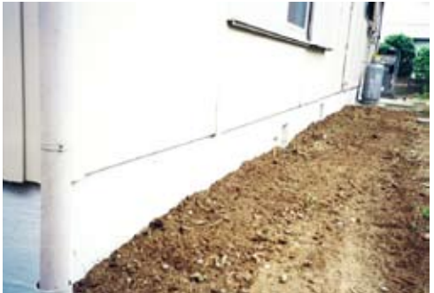
④完了（モルタル刷毛引き）
