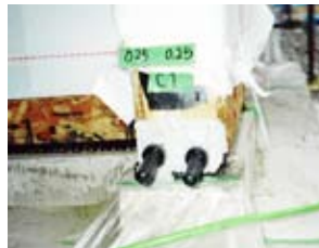
② エポキシ樹脂注入
