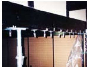
⑤エポキシ樹脂注入
