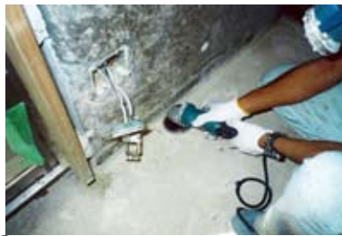
⑤入角をカッター切り
