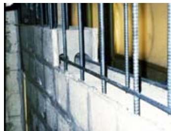
3Q-Wall 工法 施工状況
