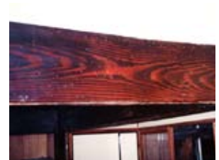
⑥汚染防止被膜除去完了
