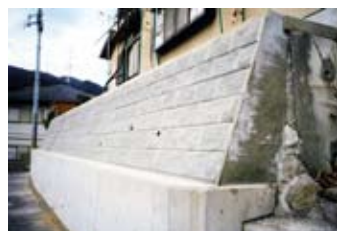
③コンクリート打設及び新設間知ブロック組積完了状況
