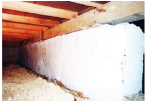
④エポキシ樹脂パテ塗付完了
