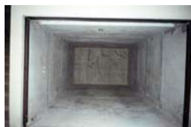
⑨施工完了
