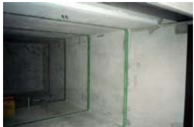
⑧目地部シーリング
