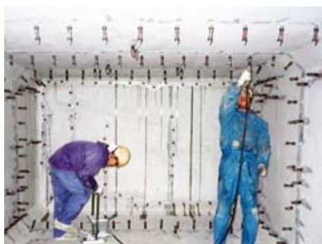
エポキシ樹脂注入
