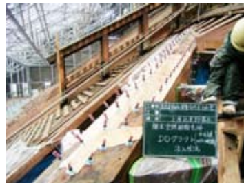
樹脂注入（ピックス工法）
