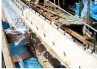
隅木埋め木接着（エポキシ樹脂注入）
