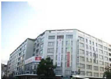
高島屋京都店 耐震補強工事
