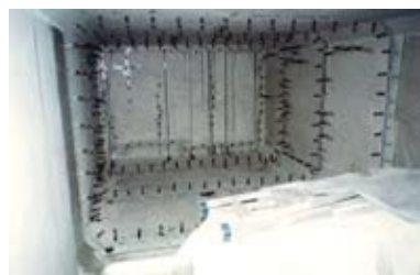
⑦エポキシ樹脂注入
