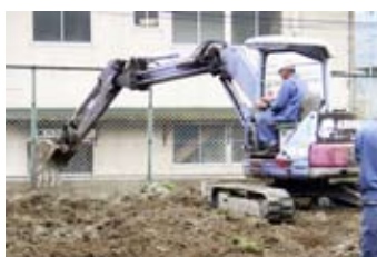
②地盤改良材の混合・攪拌状況
