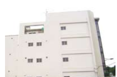
テナントビル外壁改修例
