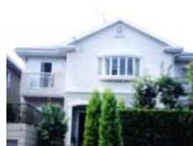
戸建住宅改修工事例
