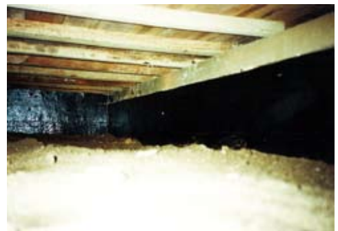
②炭素繊維シート貼付け完了
