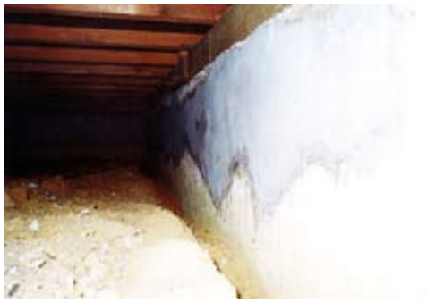
③下地処理完了
