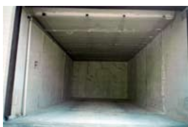
①施工前現況
