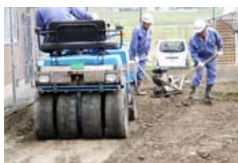
③転圧状況
