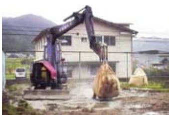
①地盤改良材の散布状況
