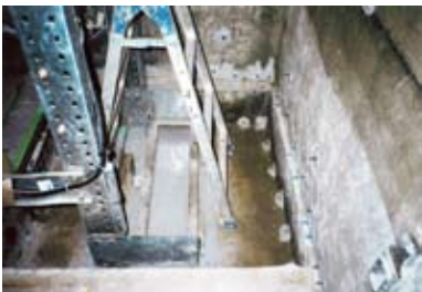
①注入用パイプ設置
