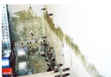
②エポキシ樹脂注入
