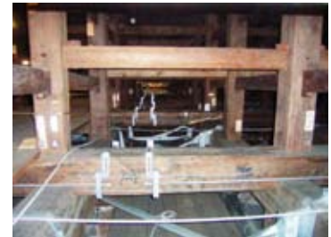
二重梁 PC 緊張工事
