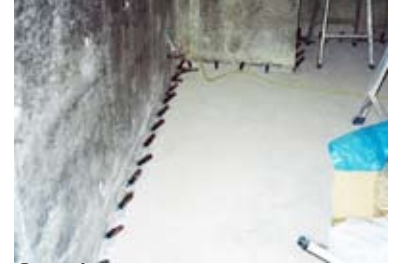
⑥エポキシ樹脂注入
