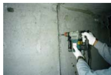
④目地部モルタル撤去
