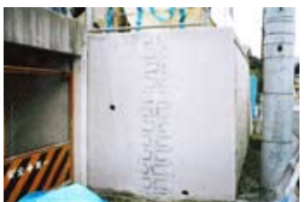
④アンカー筋設置完了
