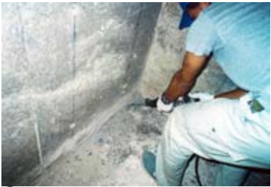
④入角のモルタル撤去
