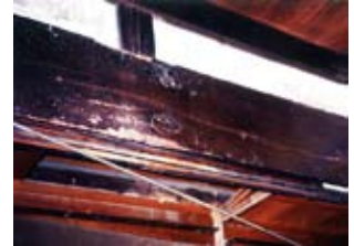
③施工前現況
