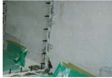
⑥エポキシ樹脂注入
