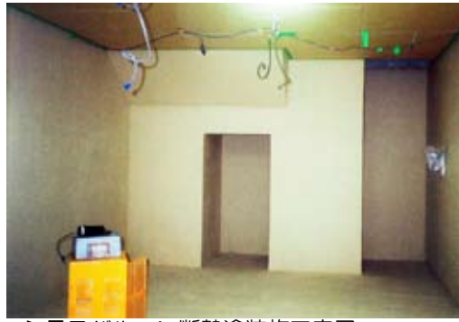
シラスバルーン断熱塗装施工完了
