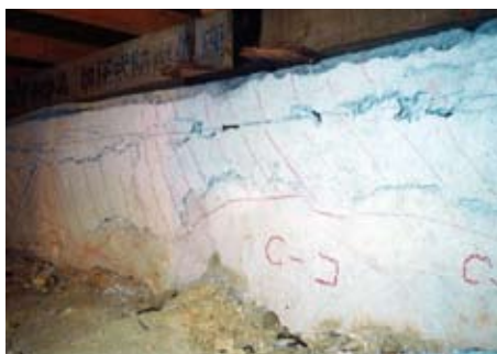
①施工前現況
