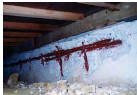
②錆鉄筋防錆処理
