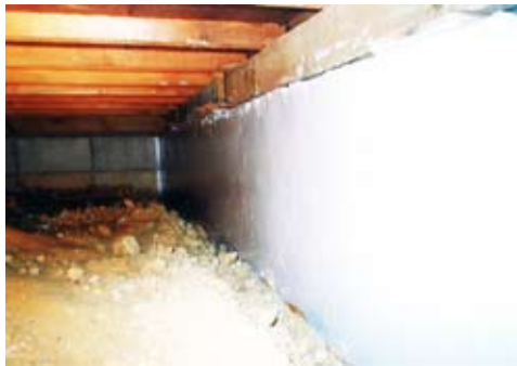
⑤エポキシ樹脂塗料塗布完了
