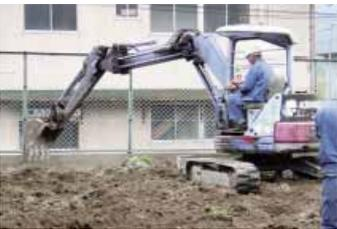
②地盤改良材の混合・攪拌状況
