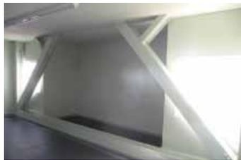
鉄骨ブレース工法
