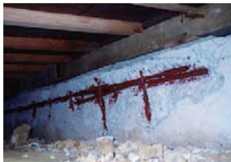
錆鉄筋防錆処理
