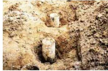
③抑止杭打設完了状況
