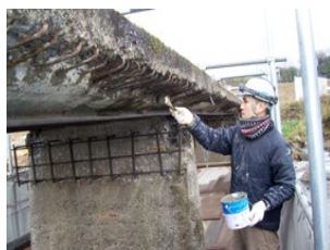
桁下面 ジャンカ部 研り後補修状況
