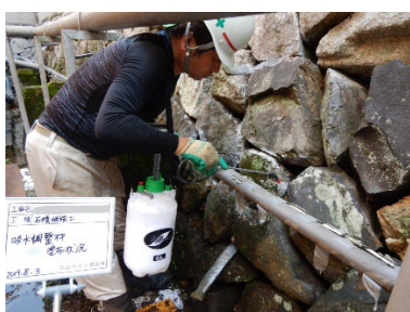
⑧目地に吸水調整剤散布
