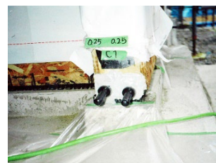
②エポキシ樹脂注入
