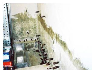
②エポキシ樹脂注入
