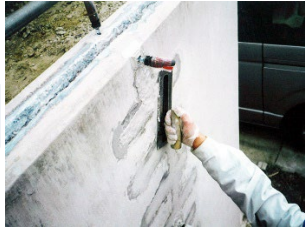
⑤エポキシ樹脂埋め戻し
