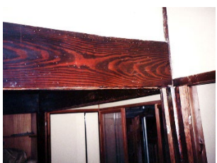
⑥汚染防止塗膜除去完了
