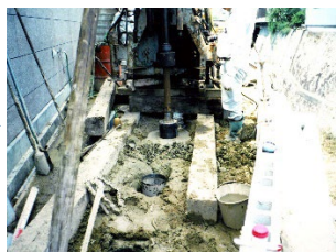
②ケーシング挿入状況
