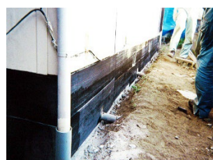
②炭素繊維シート貼付け
