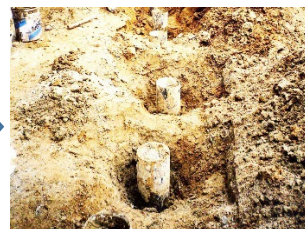
③抑止杭打設完了状況
