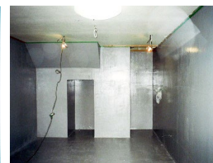
⑦クロスライニング（2層）
