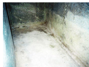
②施工前状況
