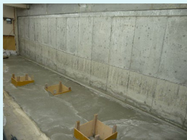
在来工法（RC耐震壁）
