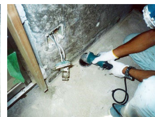
③入隅のモルタル撤去
