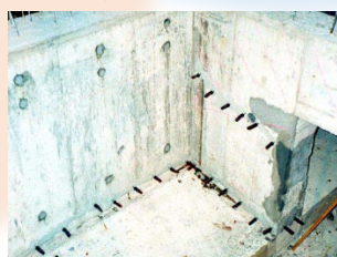
エポキシ樹脂注入
