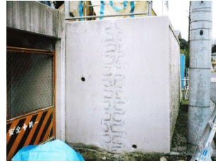
④アンカー筋設置完了
