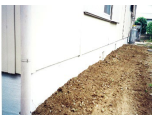
④完了（モルタル刷毛引き）
