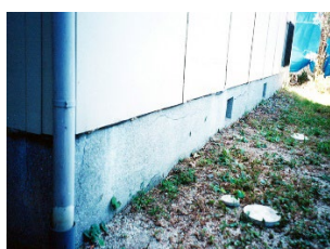
①施工前現況
