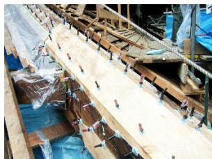
隅木埋め木接着 (エポキシ樹脂注入)
