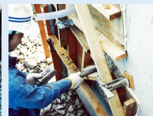
②型枠＋無収縮モルタル注入
