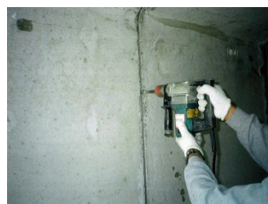
④目地部モルタル撤去
