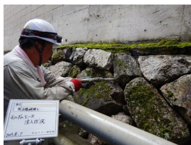
⑨モルダムエース注入
