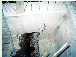
エポキシ樹脂注入
