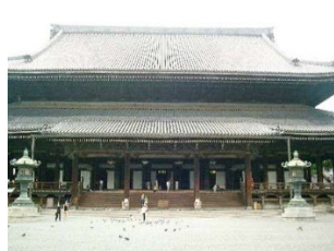
東本願寺御影堂 修復工事
