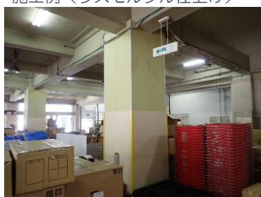
施工例（ラスモルタル仕上げ）
