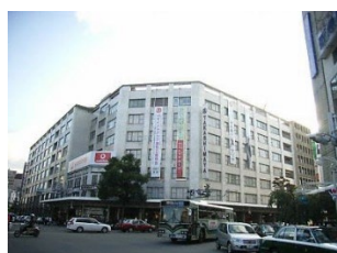
高島屋京都店 耐震補強工事
