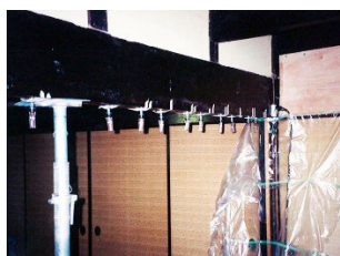
⑤エポキシ樹脂注入
