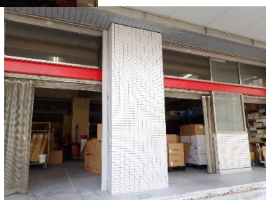
施工例（タイル仕上げ）
