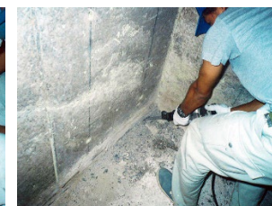
④入隅のカッター切り
