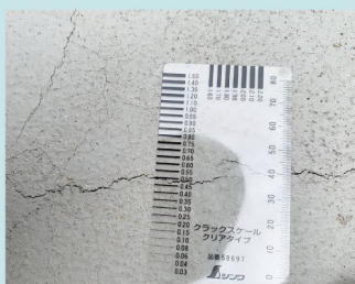
クラックスケール （ひび割れ幅測定）
