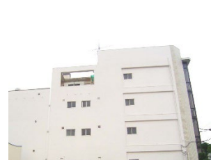
テナントビル 外壁改修工事
