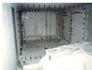
⑥エポキシ樹脂注入
