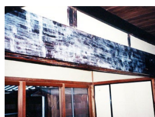
④汚染防止塗膜塗布
