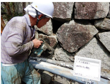
④目地モルタル撤去
