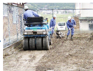
③転圧状況
