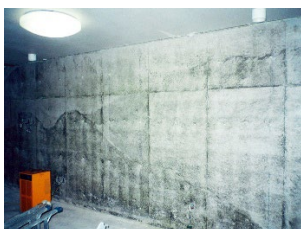
①施工前現況
