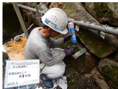
⑥水抜き加工シート設置
