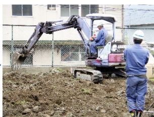
②地盤改良材の混合・攪拌状況
