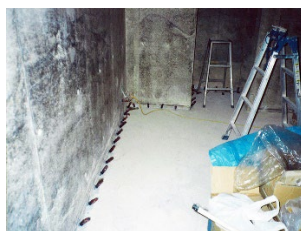
⑤エポキシ樹脂注入
