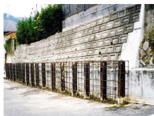
②支持杭設置、鉄筋組立状況
