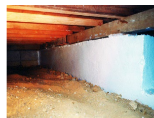
⑥アクリルウレタン樹脂塗料塗布完了
