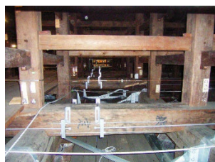
二重梁PC緊張工事
