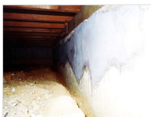
③下地処理完了
