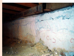
①施工前現況
