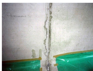
⑤欠損部補修
