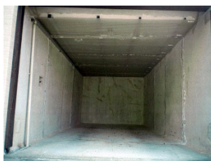
①施工前現況
