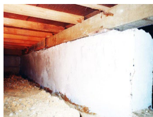
④エポキシ樹脂パテ塗布完了
