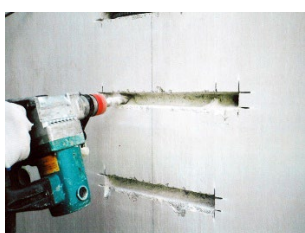
②アンカー孔はつり状況
