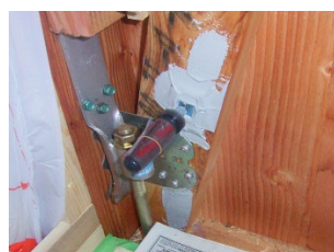
①エポキシ樹脂注入
