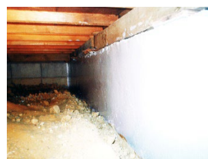
⑤エポキシ樹脂塗料塗布完了
