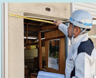
状態確認 各部寸法測定
