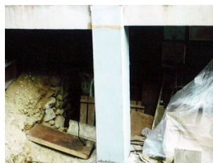
③エポキシ樹脂パテ塗布
