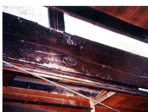
③施工前状況
