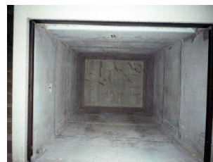
⑧施工完了
