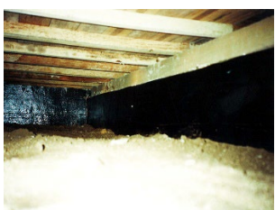
②炭素繊維シート貼付け完了
