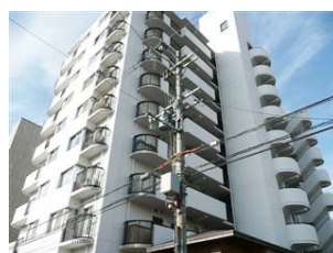
マンション 大規模修繕工事
