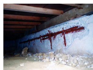
②錆鉄筋の防錆処理
