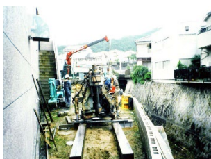
①機械搬入状況
