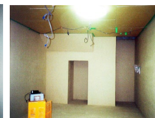
⑧シラスバールン断熱塗装 （3回塗り）
