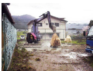
①地盤改良材の散布状況
