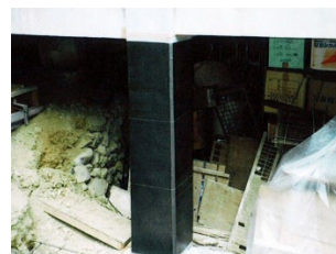
④炭素繊維シート貼付け
