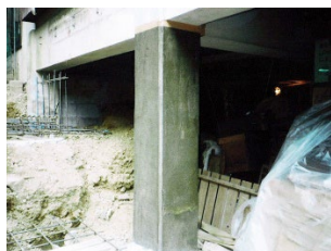
②プライマー塗布
